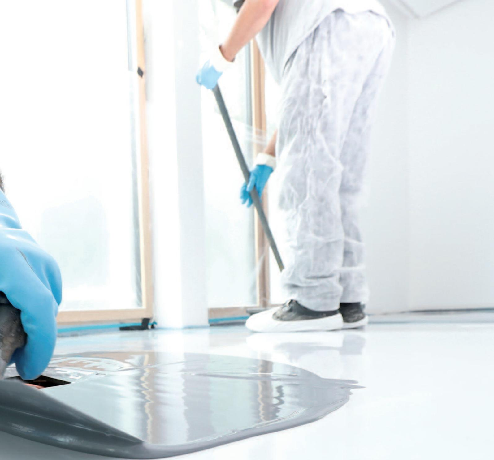
**Eine ebene und fugenlose Bodenfläche ist mit den Remmers Bodensystemen besonders einfach, schnell und sicher zu erzielen. Je nach Untergrundsituation und dem gewünschten Eigenschaftsprofil des fertigen Bodens bietet Remmers eine große Auswahl an verschiedenen Schichtaufbauten. Ob Unifarben, metallisch schimmernd oder mittels Einstreuung – die Art der Endbeschichtung lässt sich beliebig nach den eigenen Vorstellungen und Designansprüchen umsetzen.**
