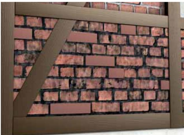
1 Ersetzen oder Ergänzen beschädigter Steine mit Restauriermörtel SK
